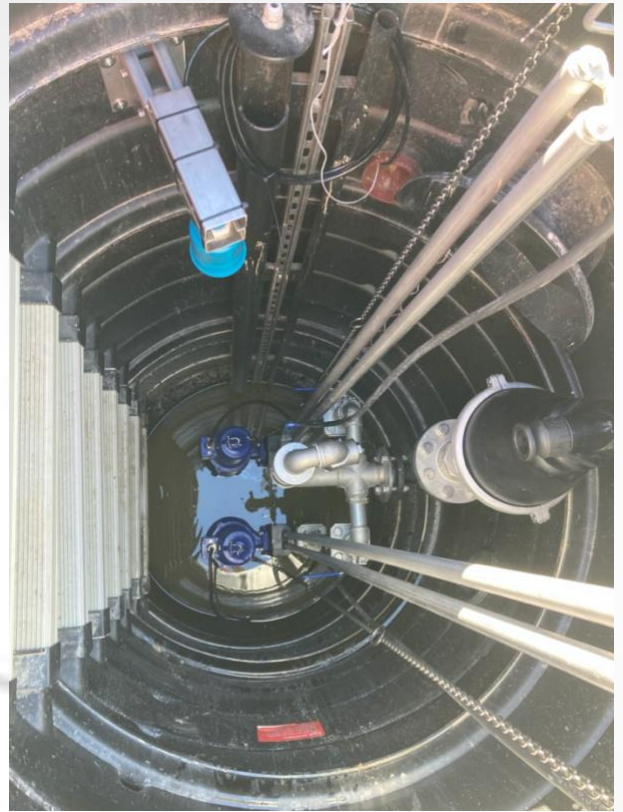
ROMOLD Pumpenschacht mit AIRVALVE Abwasserventil
