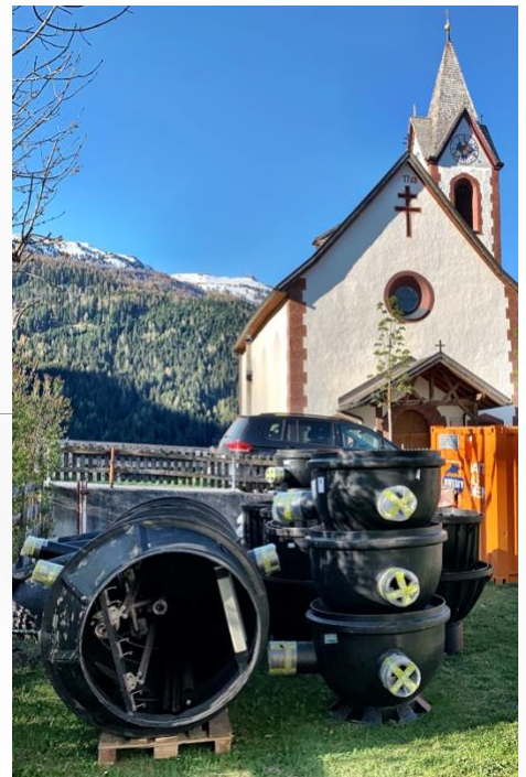
Lagerplatz Pumpenschacht / PE-Kanalschächte
